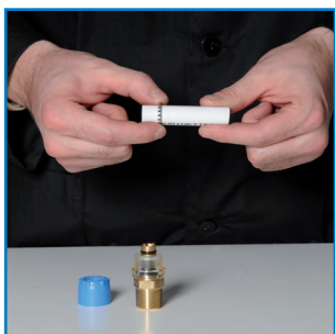
3) Снять зажим из нержавеющей стали (только если чувствуете скольжение).
